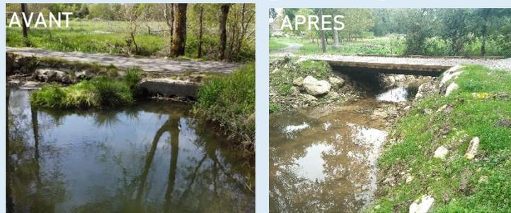
Suppression ou remplacement de 4 ouvrages de franchissement qui obstruaient l'écoulement de l'eau et constituaient un obstacle à la continuité écologique (empêchant le libre transit des sédiments et des espèces piscicoles).
