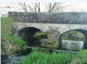
Restauration de la continuité piscicole par un fractionnement de la hauteur de chute en aval de 4 ponts routiers.
