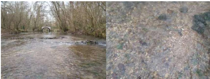
Photo 16 : Haut fond ayant fait l'objet d'une recharge en aval du pont de Tende
