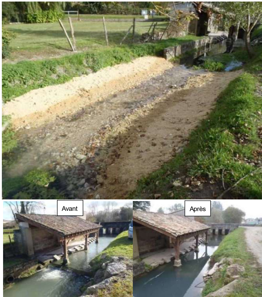
Photo 9 : Exemple de batardeau remplacé par une banquette -radier (taillon, 2015)
