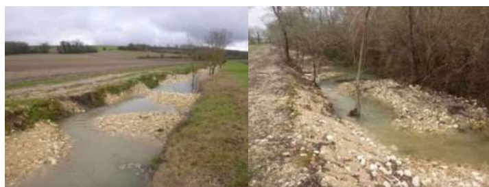
Photo 15 : Exemples de banquettes minérales alternées (SI du Bassin du Né, 2018)
