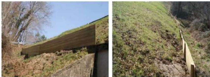
Photo 11 : Exemple de dispositifs de protection pour empêcher l'accès à la voirie
