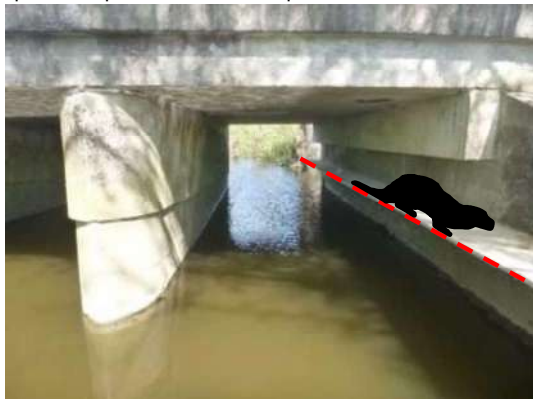
Photo 10 : Exemple d'encorbellement fixé sous un pont départemental sur la Seugne à Château-Renaud (Pons)
