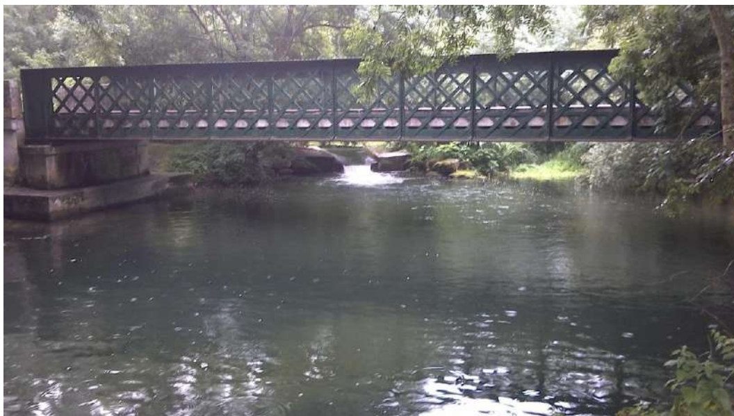
Photo 36 : Pont amont de la RD 234 E à Château-Renaud
