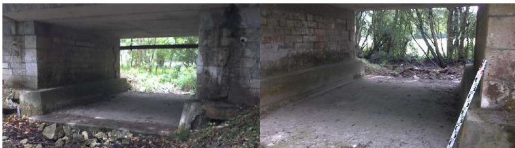
Photo 43 : Ouvrages centraux sur la RD 2232 E 2 entre Lijardière et St-Seurin-de-Palenne
