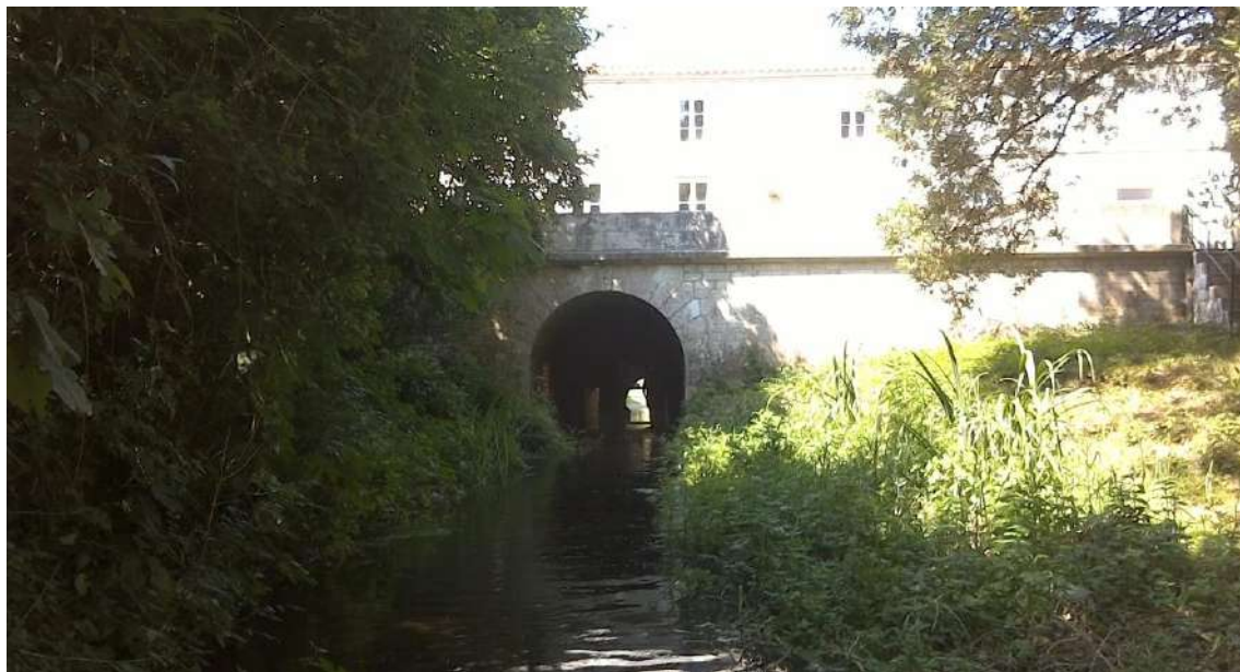
Photo 53 : Pont de la RD 128 sur un bras de la Seugne en amont du Moulin de Courcoury
