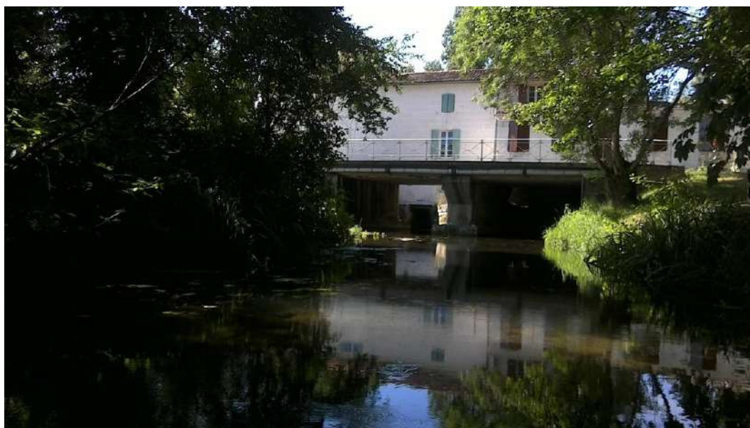
Photo 45 : Pont de la RD 136 sur le bras gauche en amont du moulin de Colombiers
