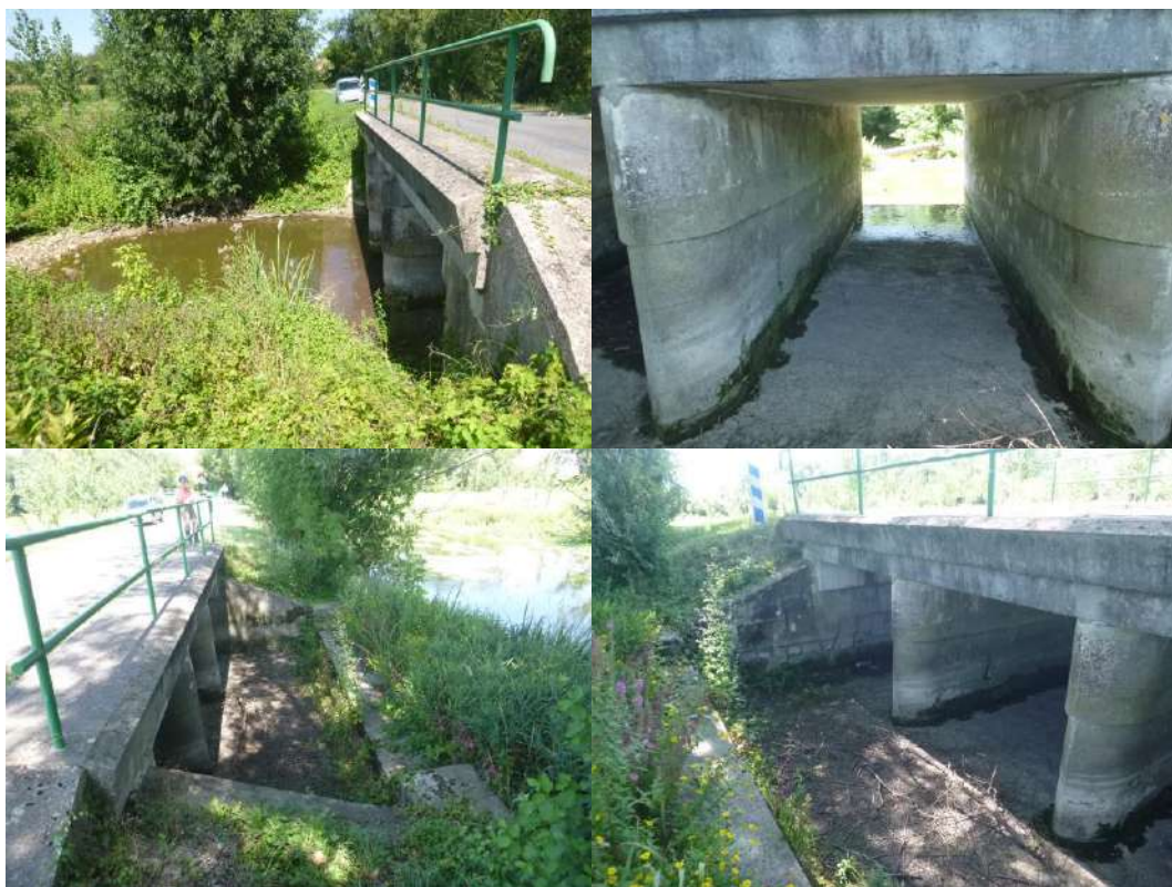
Photo 39 : Troisième pont de la RD 234 E5 à Château-Renaud
