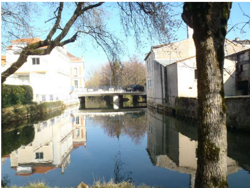
Photo 34 : Pont de la RD 142 à Pons (bras central)
