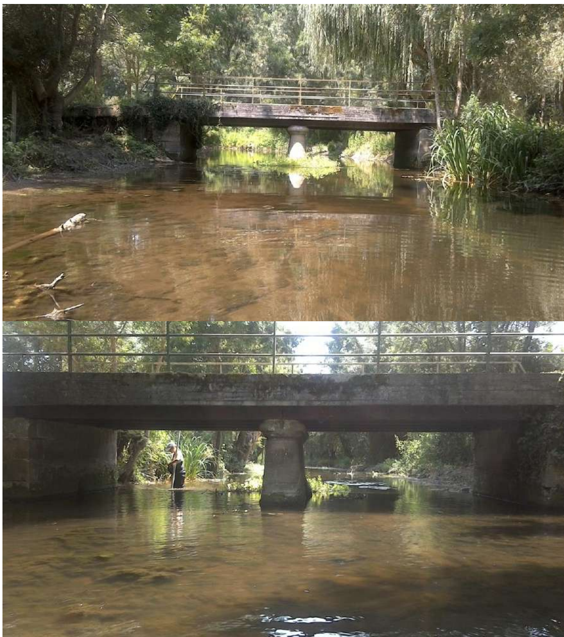
Photo 61 : Pont de l'Anglade sur la Seugne à Les Gonds
