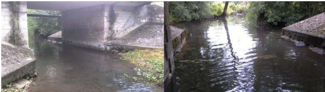
Photo 42 : Pont de la RD 232 E 2 sur le bras gauche à Lijardière
