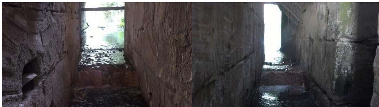
Photo 54 : Chutes résiduelles des coursiers du moulin de Courcoury
