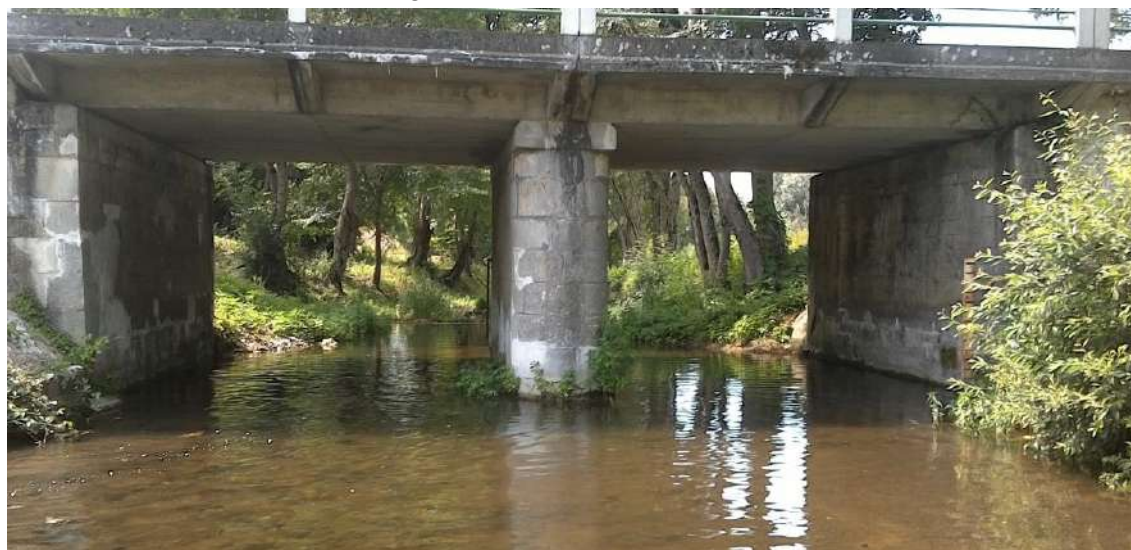
Photo 50 : Pont de la RD 128 sur l'Etier de Courpignac en aval du Moulin de Courpignac
