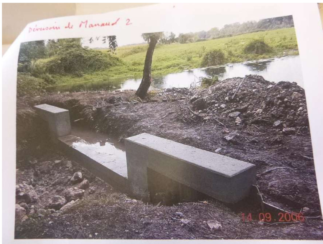
Photo 25 : Création d'un déversoir en béton en amont du Moulin de Courpignac (UNIMA, 2006)
