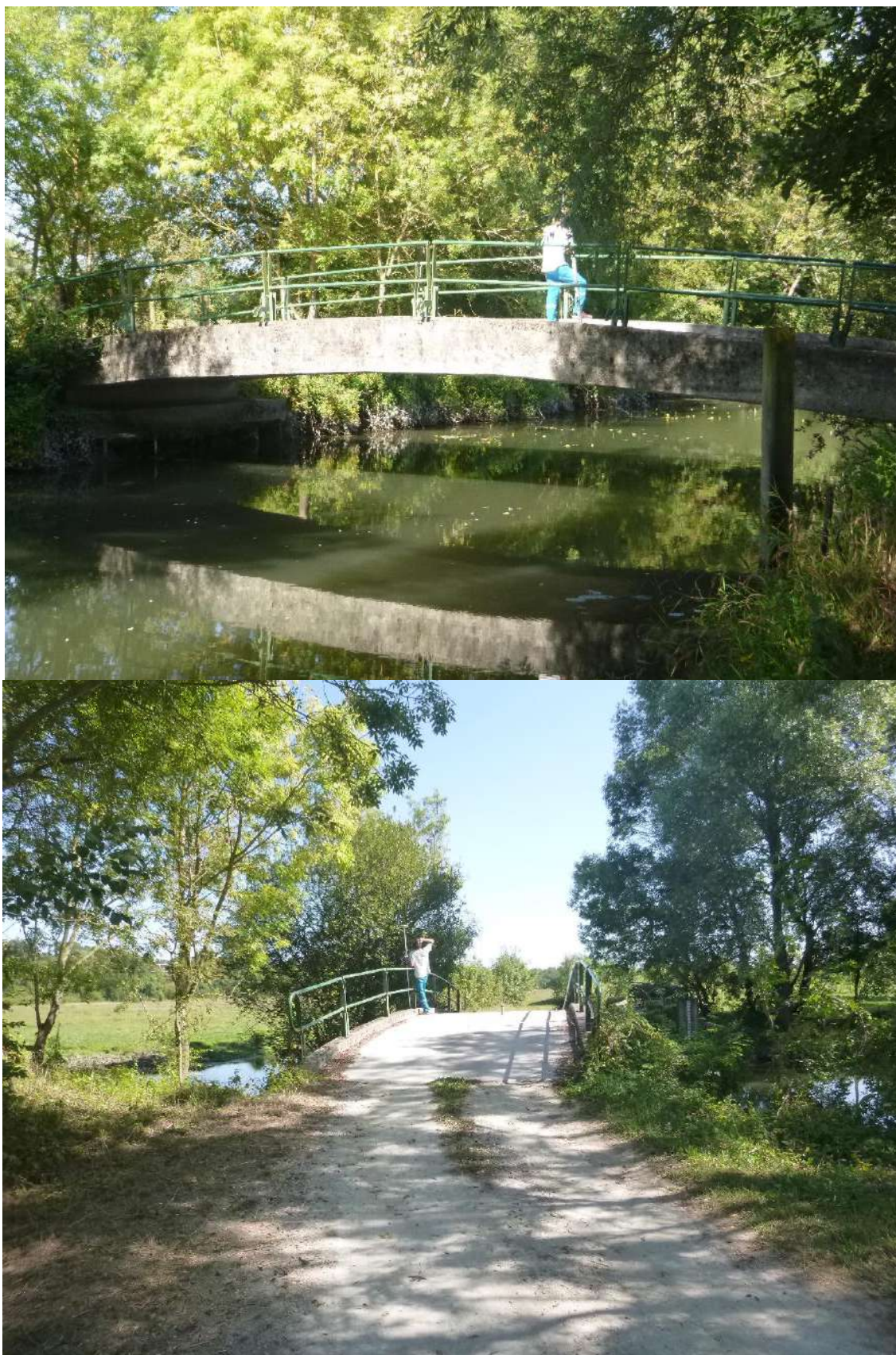
Photo 63 : Pont communal du lieu-dit « Prairie du bourg » sur la Seugne à Courcoury
