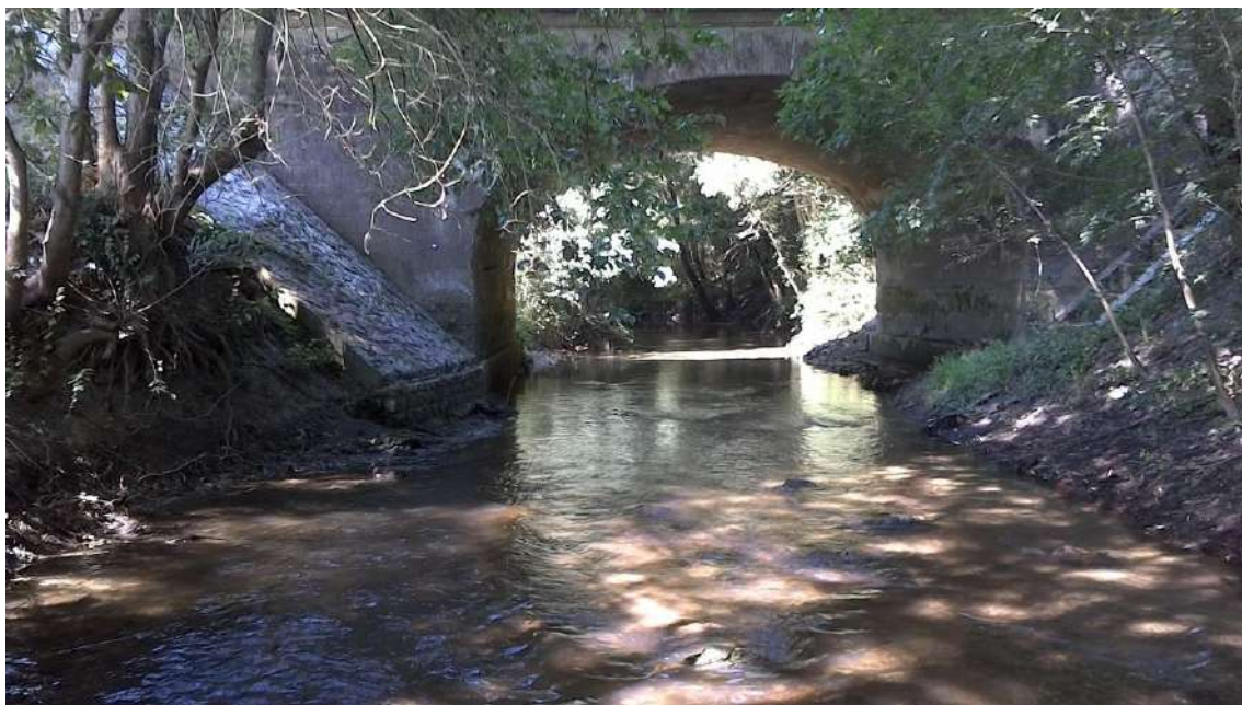
Photo 55 : Pont de la RD 128 sur un bras Est de la Seugne en aval du Moulin de Chantemerle
