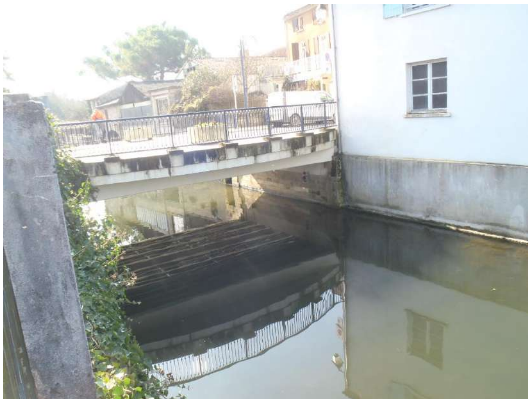
Photo 33 : Pont de la RD 142 à Pons (bras de gauche)
