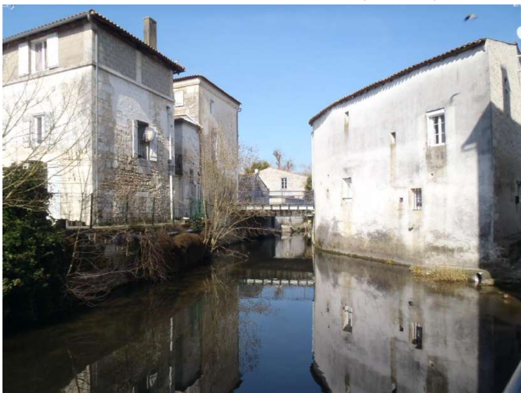
Photo 35 : Pont de la RD 142 à Pons (bras de droite)
