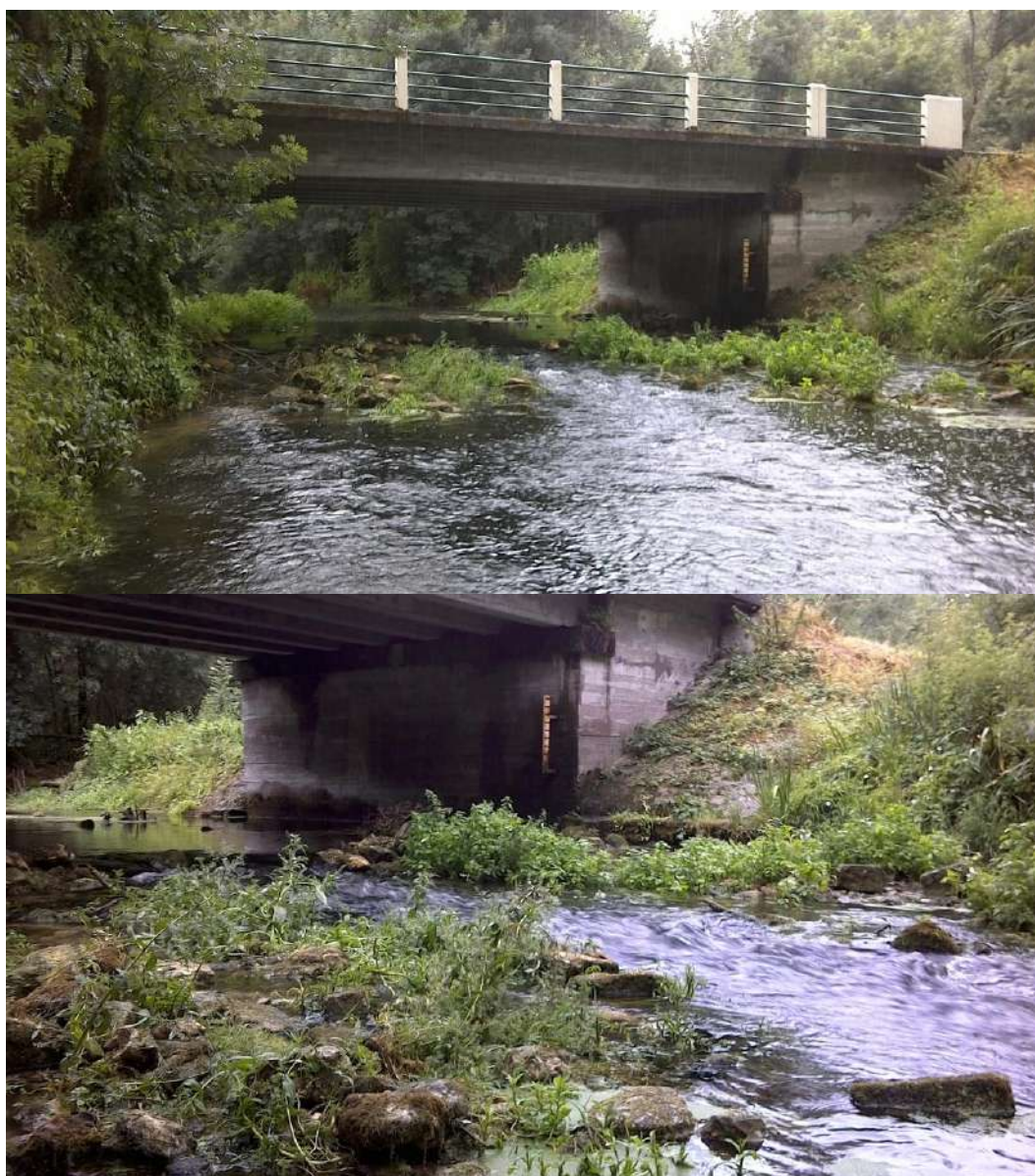
Photo 46 : Pont de la RD 136 sur l'Etier mort à Colombiers
