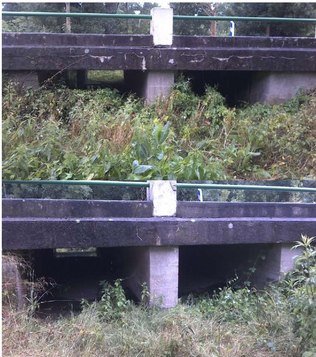
Photo 47 : Ouvrages centraux sur la RD 136 entre Colombiers et Mérignac
