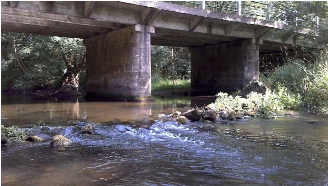
Photo 51 : Pont de la RD 128 sur la Seugne (bras central)
