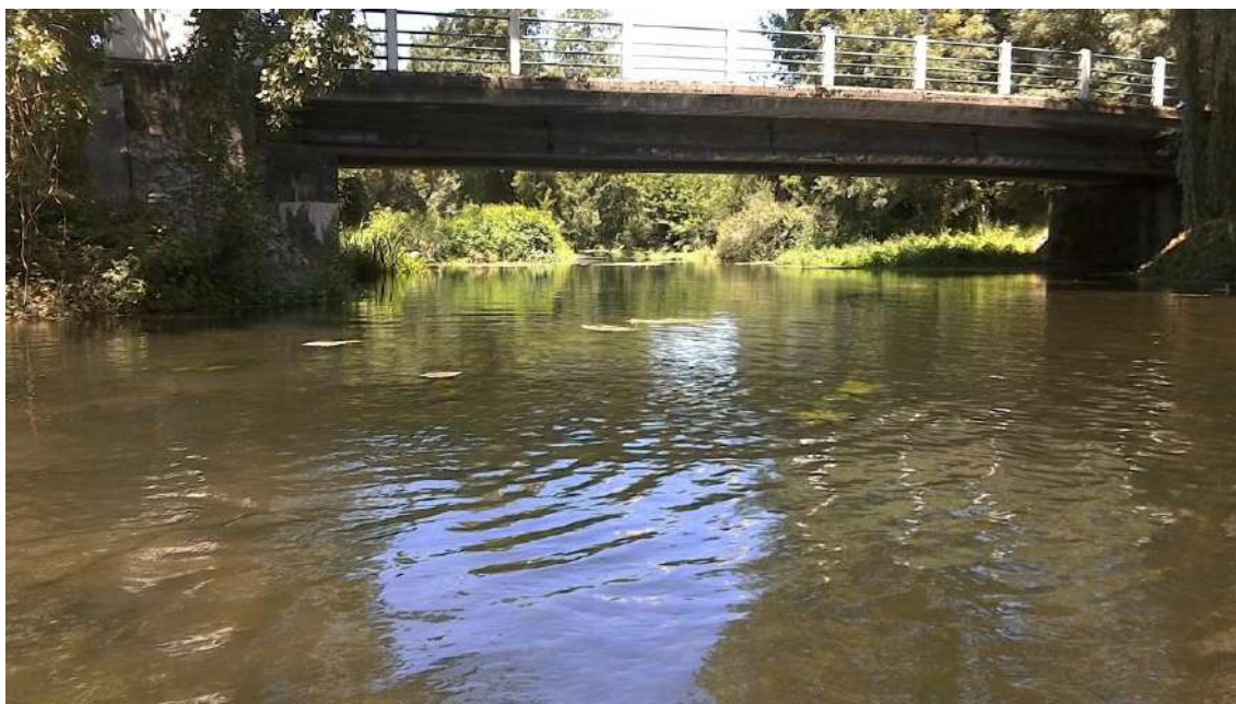
Photo 49 : Pont de la RD 136 sur la Seugne en aval du Moulin de Mérignac à Colombiers
