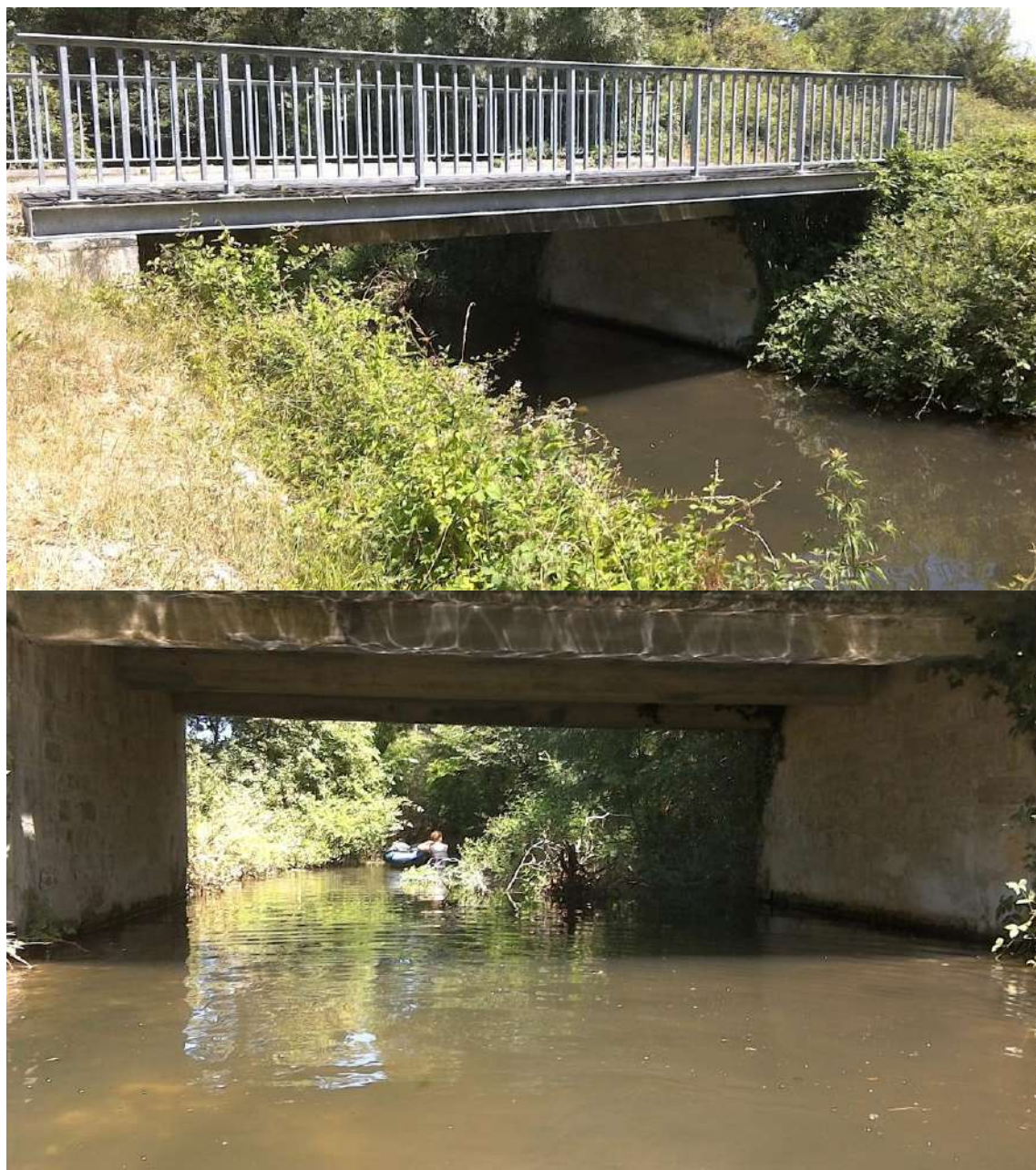
Photo 60 : Pont de la Fossade sur la Seugne entre Courcoury et Saint-Sever-de-Saintonge
