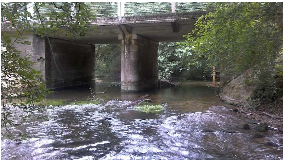
Photo 52 : Pont de la RD 128 sur l'Etier du Gua en aval du Moulin du Gua de Courcoury
